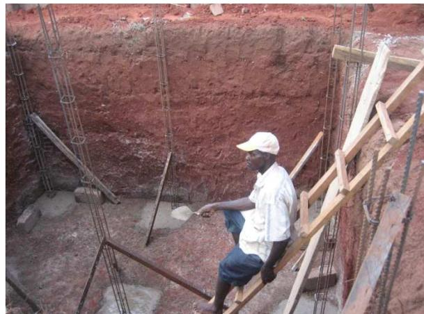
*Gemauerte und zementierte Toilettengrube*
